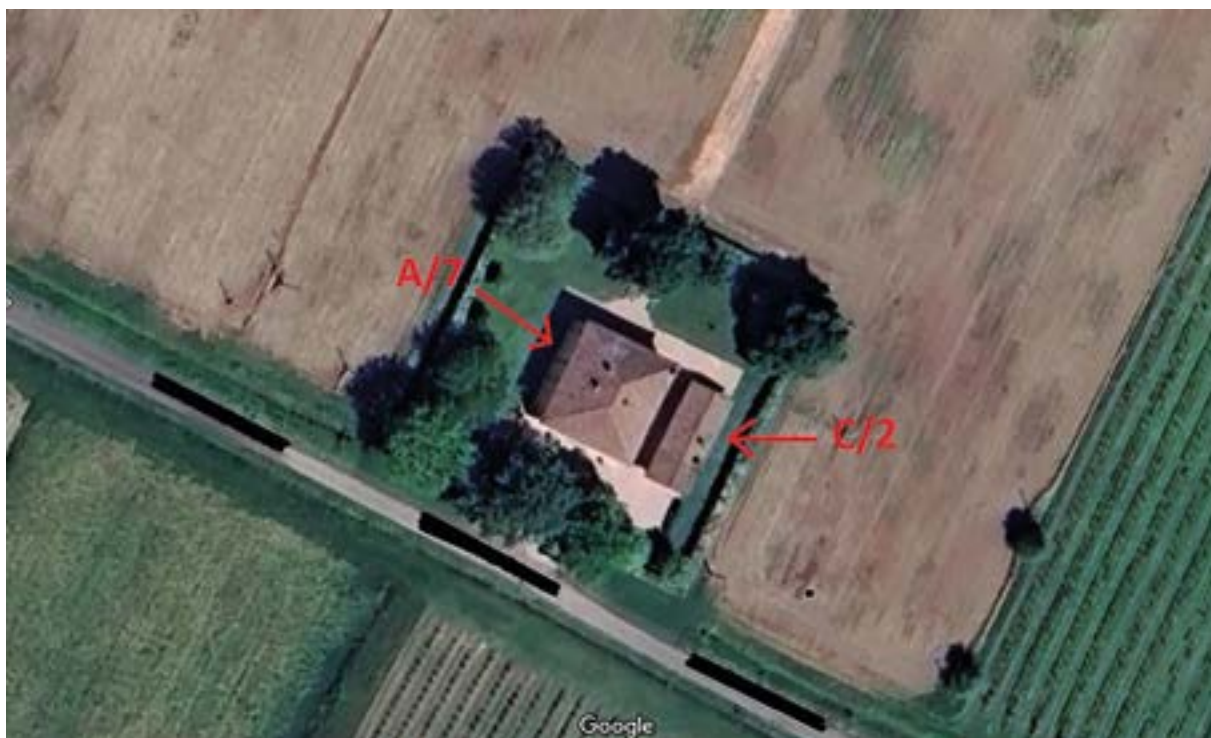
Figura 70. Abitazione n. 2 con fabbricato C/2 disgiunto visti dall'alto
