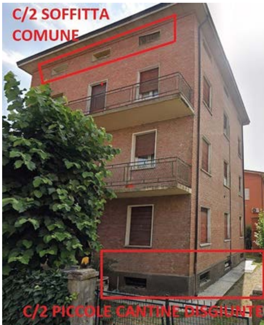
Figura 68. Abitazione n. 1 con piccole cantine disgiunte situate nel seminterrato e soffitta comune
